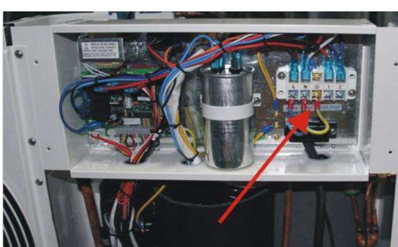
**Примечание:** В случае трехфазных моделей, замена двух фаз может привести к работе электродвигателей в обратном направлении, что может привести к повреждениям. По этой причине, устройство оснащено встроенным защитным устройством, которое размыкает цепь при неправильном соединении. Если загорается красный индикатор внизу предохранительного устройства, **Вы должны поменять местами подключение двух фазных проводов.**
