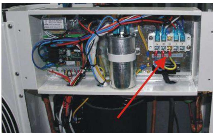
**Uwaga:** W przypadku modeli trzyfazowych, zamiana dwóch faz może sprawić, że napędy elektryczne zaczną pracować w odwrotnym kierunku, co może powodować uszkodzenia. Z tego powodu, jednostka wyposażona jest we wbudowany bezpiecznik, który odcina dopływ prądu jeżeli podłączenie nie jest prawidłowe. Jeżeli świeci się czerwona dioda LED nad tym urządzeniem zabezpieczającym, **należy zamienić podłączenie dwóch kabli fazowych.**
